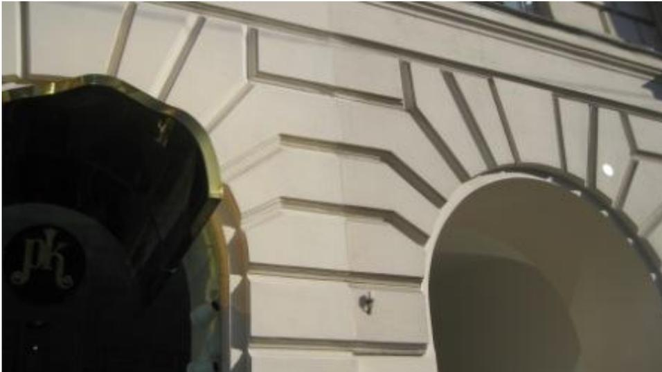
Sehr deutlich hebt sich der beschichtete Fassadenteil durch seinen Glanz, seine Reinheit und Helligkeit von seiner Umgebung ab... und das fast ein Jahr nach dem Reinigen und der Aufbringung des Schutzes!
