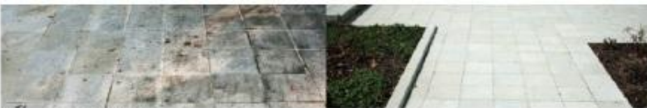
Reinigung von Kunststeinen Betongranitsteine vor und nach der Reinigung. Dachterasse eines Industrieunternehmers in Linz.
