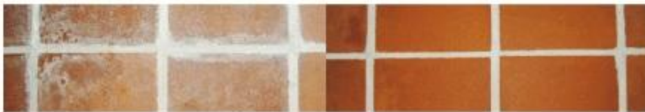
Fliesensanierung Reinigung von Oberfläche und Fugen eines stark begangenen althabsbischen Cobboboden.
