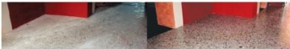
Bauendreinigung Wir entfernen Ihren Bauschutt – Von der Grob- bis zur Feinreinigung.
